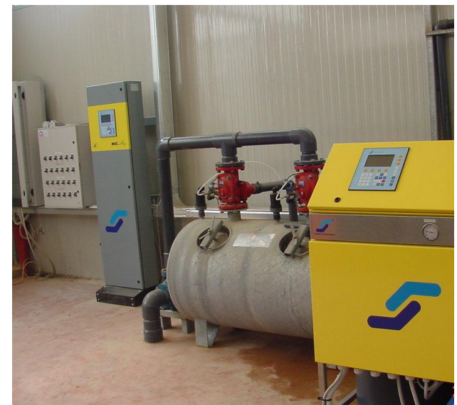
Banco di Fertirrigazione con «miscelazione parziale»
